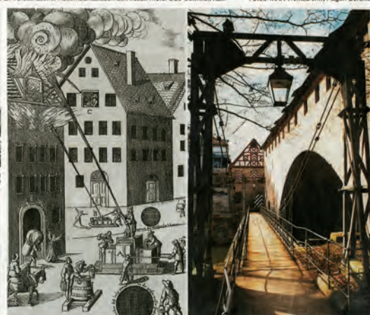
In Nürnberg kam erstmals im 17. Jahrhundert eine Feuerspritze zum Einsatz, die einen gleichbleibenden Wasserstrahl erzeugte (links). Als Deutschlands erste freischwebende Hängetriecke gilt die 1824 erbaute Kettmaaschine (rechts). – Per Erfindung noch heute seine Funktion. Fotos: Geschichte für Alle e. V., Altstadtfreunde
